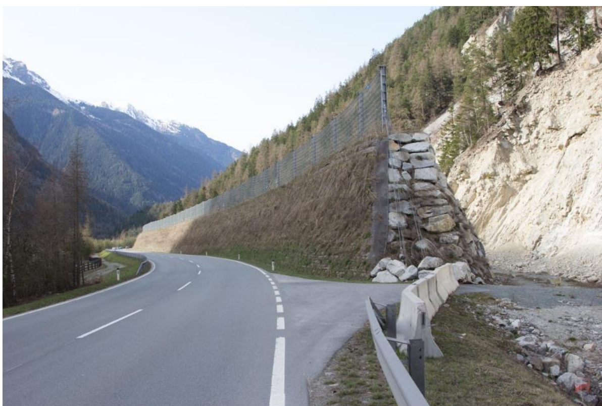
Figur V3.1 Eksempel på skredsikring av vei
